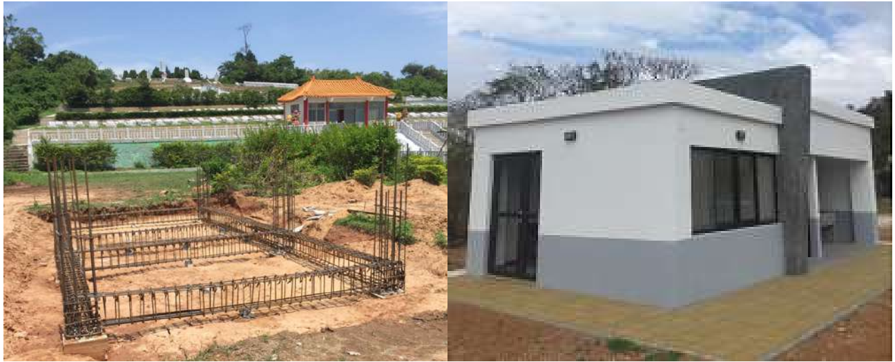
107 年補助金門縣軍人忠靈祠辦理烈嶼管理室及廁所新建工程
